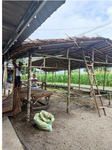
Gambar 1.2 Tahapan Pemasangan atap Balerong (dokumentasi penulis)
