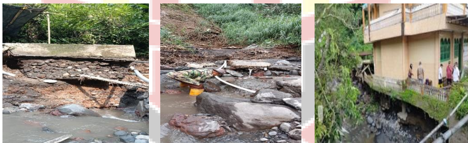
Gambar 3.3 Kondisi Nagari Andaleh Pascabencana 2024
