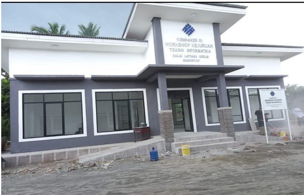
Lampiran 16 Gedung kemnaker RI workshop kejuruan teknik informatika balai latihan kerja komunitas
