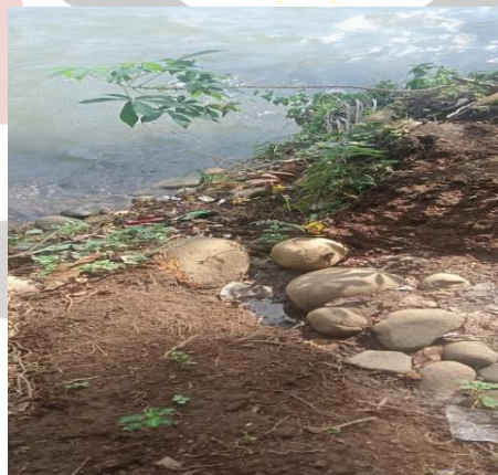
Gambar II. Longsor akibat banjir
