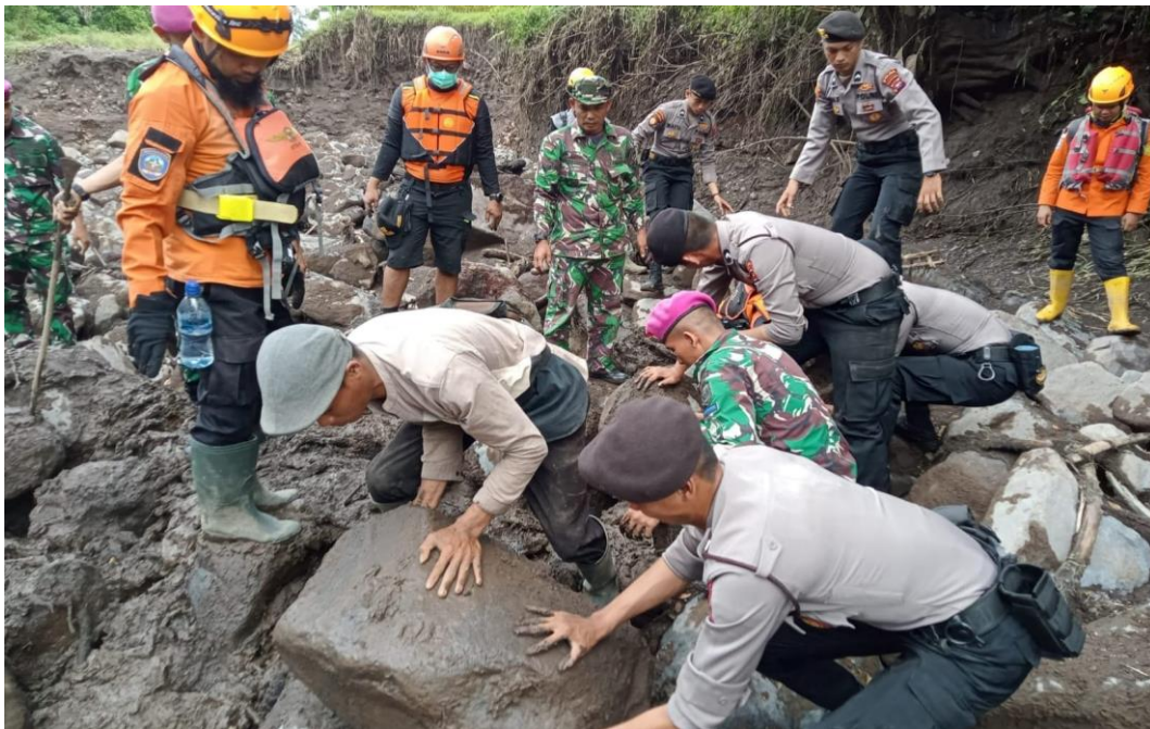
Gambar 13. Proses Pembersihan Sungai
