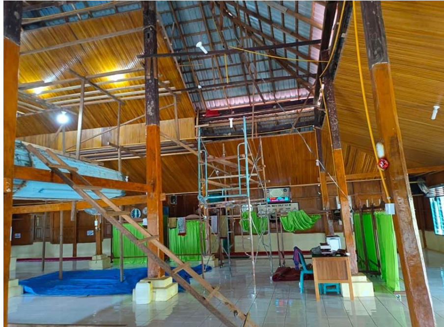
Gambar 3.7: Tahap Renovasi Loteng (Foto: Dokumentasi Penulis)
