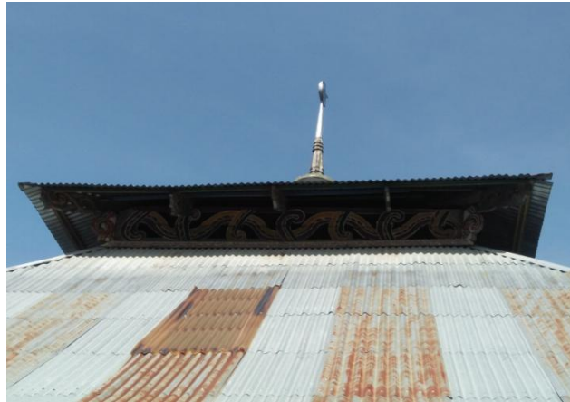
Gambar 3. Atap masjid kuno Lempur Tengah (Dokumen: Neci: 2017)
