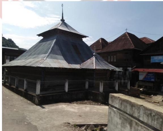
Gambar 4. Atap masjid kuno Lempur Tengah (Dokumen: Neci: 2017)
