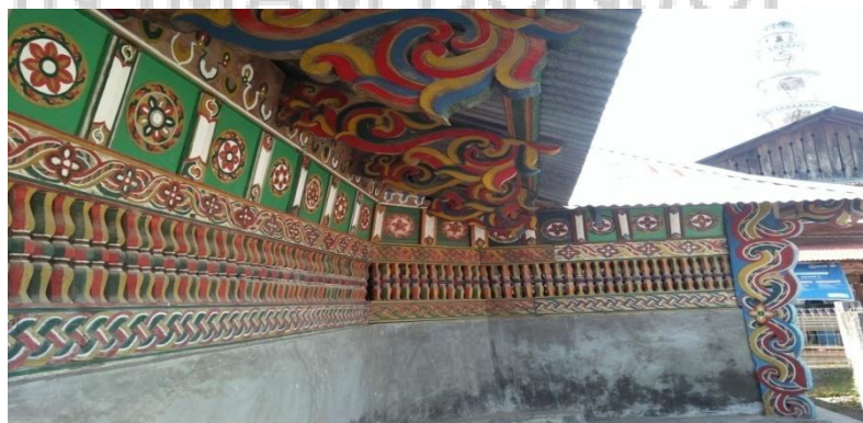
Gambar 10. Jendela/ jeruji, dinding masjid kuno Lempur Tengah (Dokumen: Neci: 2017)
