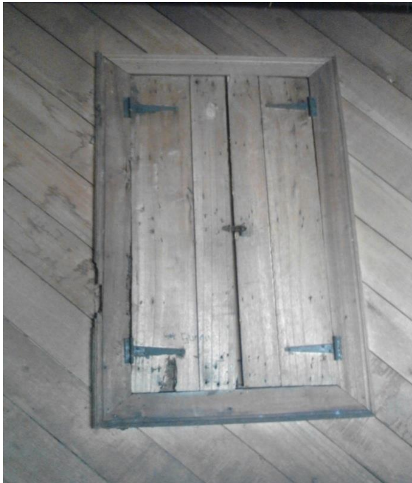
Foto No 7 : Jendela Surau Gadang Syekh Bintungan Tinggi
