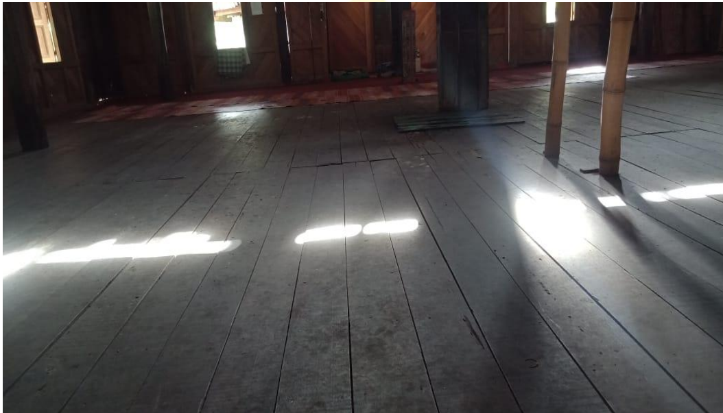
Foto No 8 : Lantai Surau Gadang Syekh Bintungan Tinggi
